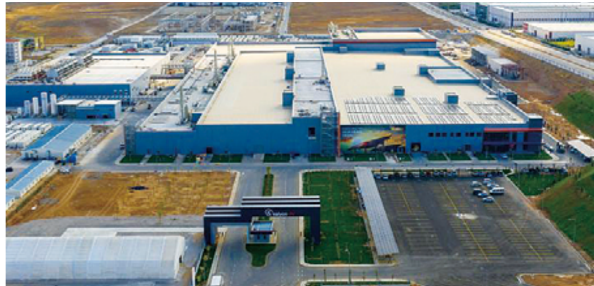
俯瞰中国电科—土耳其 Kalyon 集团光伏产业园
